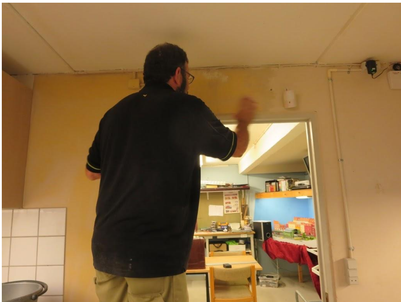
Som I kan se, er det forholdsvis nemt at fjerne den gamle maling, fast arbejde!
